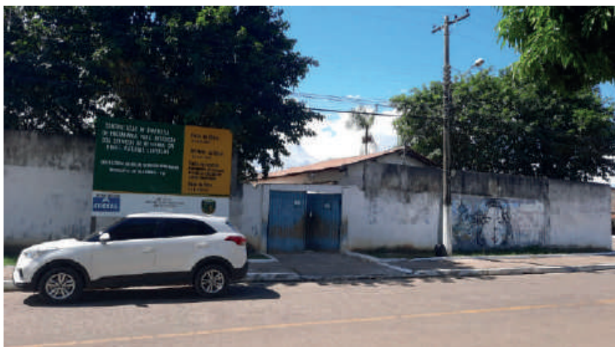
Figura 1 - Vista da fachada da escola Salomé Carvalho.
