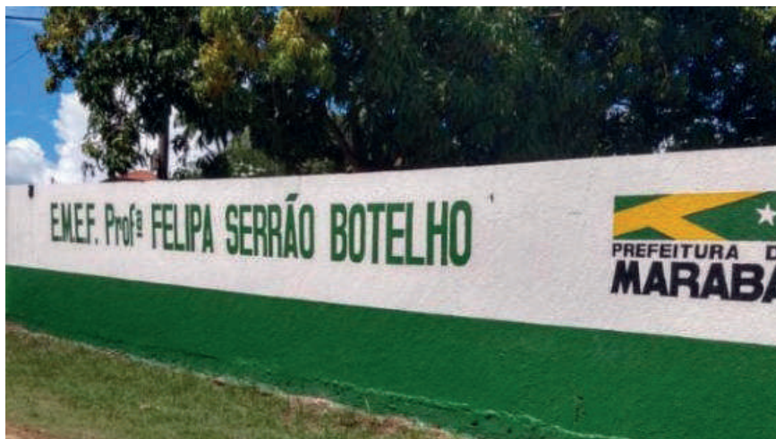
Figura 3 - Fachada da escola municipal Professora Felipa Serrão Botelho.
